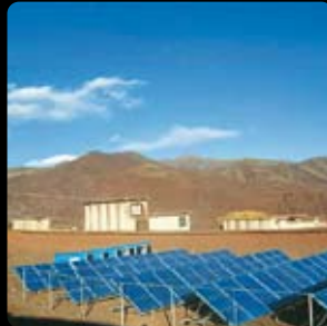
Pequeña central eléctrica
