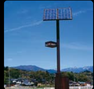
Iluminación de carreteras
