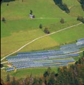
Pequeña central eléctrica
