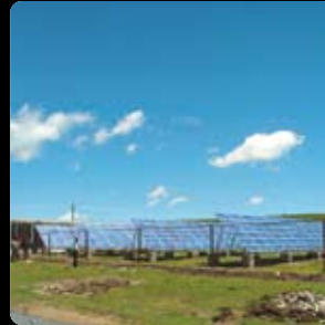
Pequeña central eléctrica
