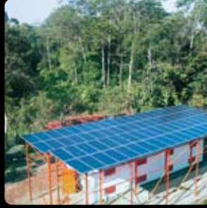
Sistema de telecomunicaciones
