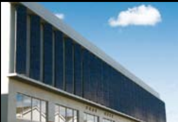
Las instalaciones de la fábrica están equipadas con nuestros sistemas fotovoltaicos
